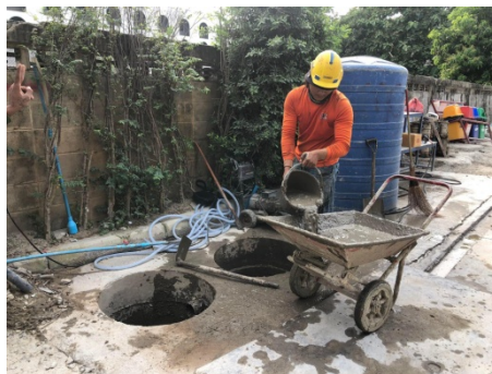
ภาพที่ 4-21 ชุดลอกตะกอนที่บ่อพักน้ำทั้งก่อนระบายออกสู่ภายนอกโครงการ
