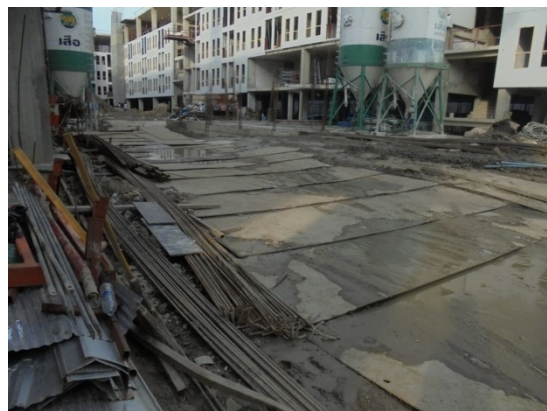
ภาพที่ 4-9 ปรับสภาพพื้น บดอัดให้เป็นที่เรียบ วางเหล็กหนาเพื่อเตรียมการทำเสาเข็มฐานราก
