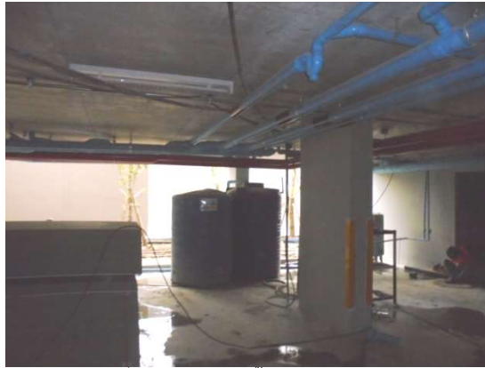
ภาพที่ 4-33 ถังสำรองน้ำใช้ในโครงการ
