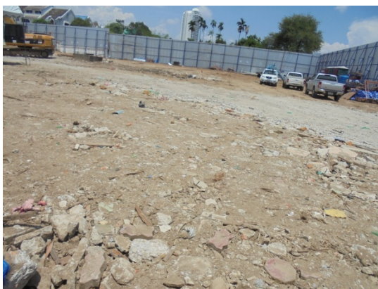
ภาพที่ 4-9 ปรับสภาพพื้น บดอัดให้เป็นที่เรียบ วางเหล็กหนาเพื่อเตรียมการทำเสาเข็มฐานราก
