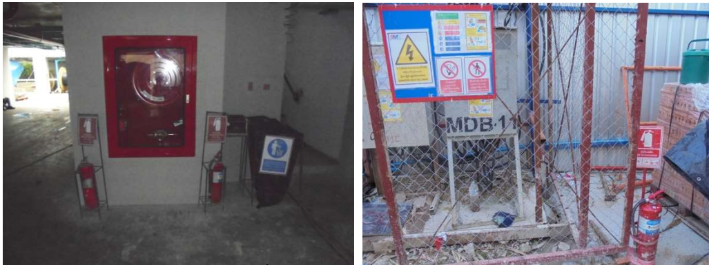
ภาพที่ 4-16 ถึงเคมีดับเพลิงตั้งไว้บริเวณที่เสี่ยงต่อการเกิดเพลิงไหม้พร้อมคู่มือการใช้งาน
