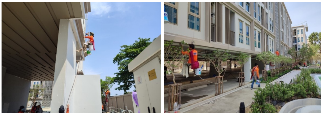
ภาพที่ 4-32 ปิดผนังอาคาร และคนงานสวมใส่เข็มขัดนิรภัยในการทำงานบนที่สูง
